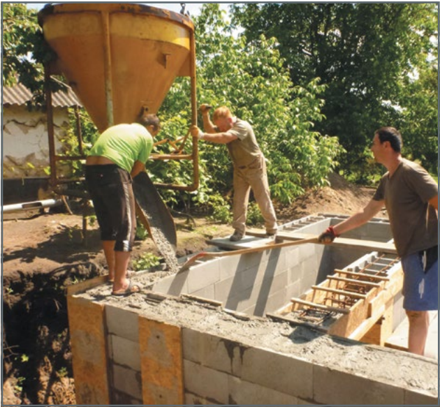
Заливання стрічкового фундаменту бетоном
