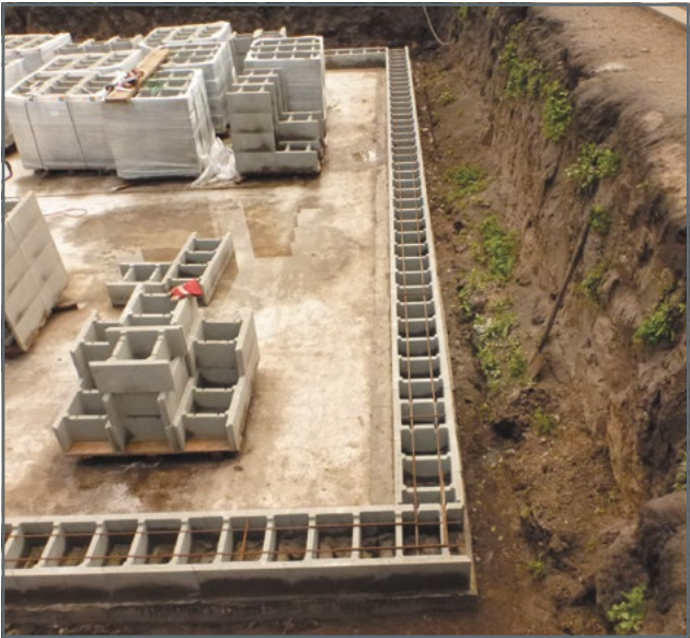
Монтаж блоків незнімної опалубки (510х400х235)
