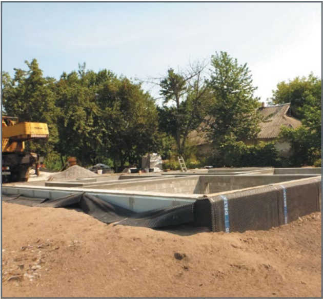
Утеплення и гідроізоляція фундаменту
