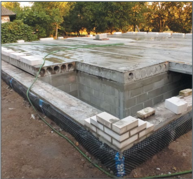
Монтаж перекриттів и стін будинку
