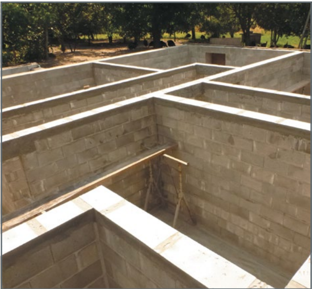
Підготовка основи під перекриття
