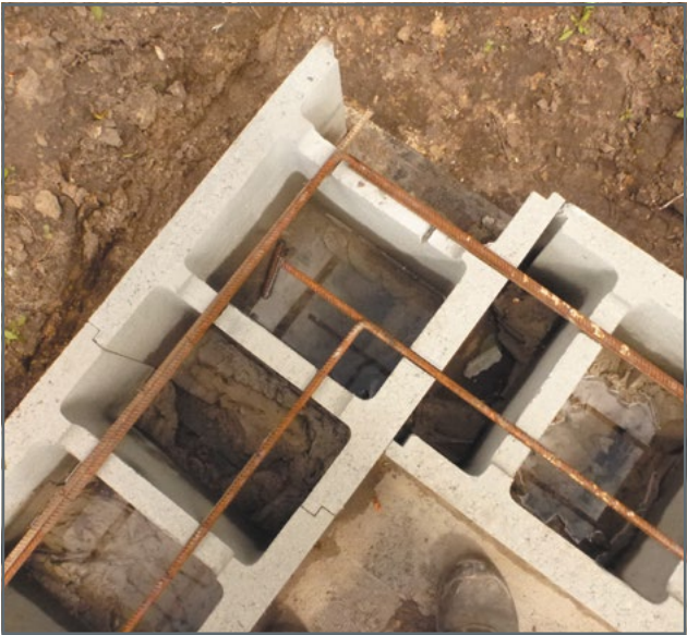
Підготовка арматурного каркасу
